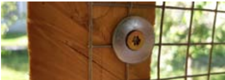
Befestigung der Gitter
